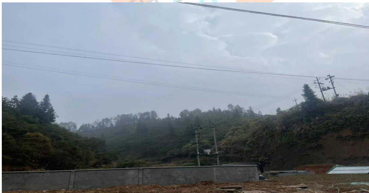
东侧-通信线、架空通信线、架空电力线、变压器、10kv 堆西线、 10kv 茅前线
